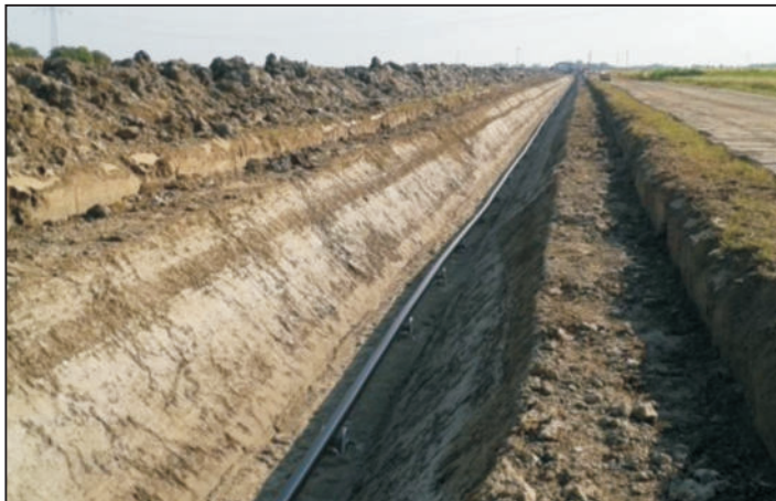
Der Bau einer Hochspannungsleitung als Erdkabel.
